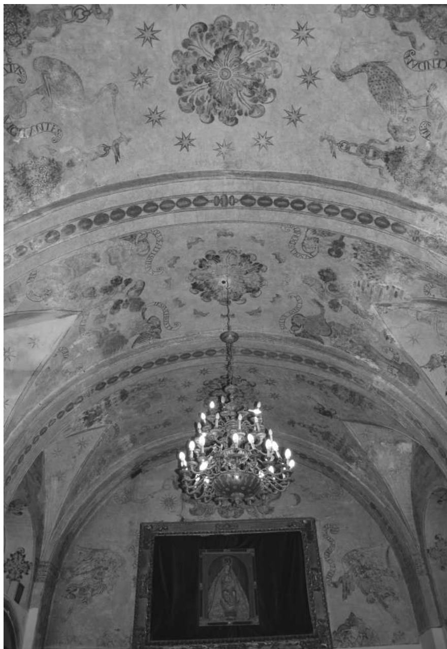
Lám. 8. Bóveda de la sacristía.
