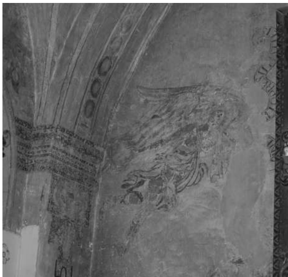
Lám. 2. Detalle del muro este.
