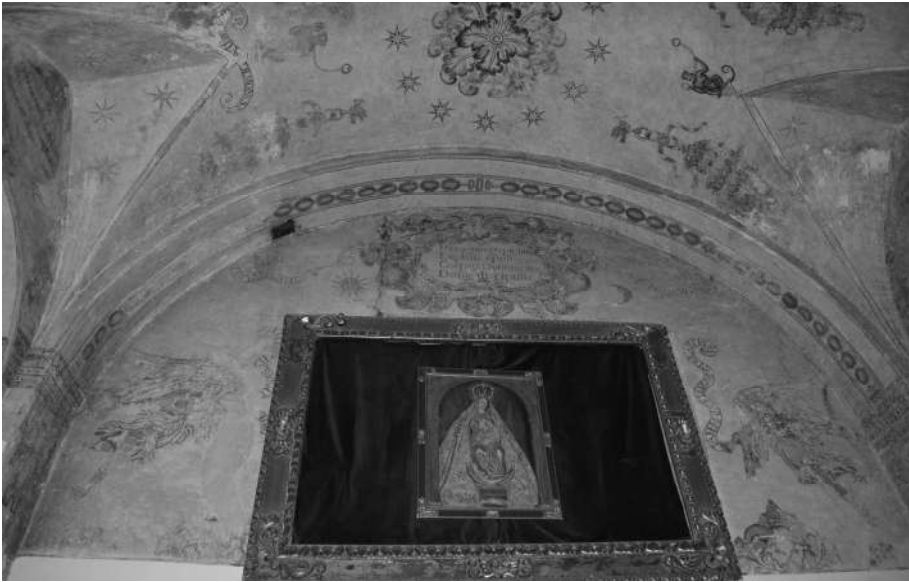
Lám. 1. Muro este de la sacristía.
